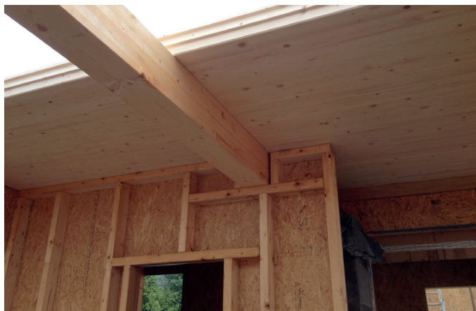
So ist Ihr Haus schnell errichtet: mit der zeitsparenden Holzständerbauweise.
